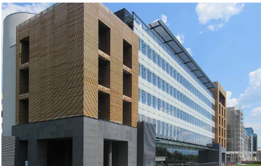
2016-2020 -Ristrutturazione degli Allianz Headquarters a Trieste
